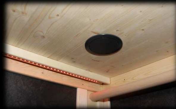
Enceintes stéréo intégrées dans le plafond.
